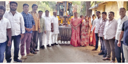
సీసీ రోడ్డు పనులను ప్రారంభిస్తున్న కార్పొరేటర్ లక్ష్మి
